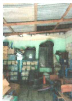
ESTRUCTURA DE TECHO, SUSTITUCION DE ESTRUCTURA DE TECHO EN MAL ESTADO, CUBIERTA DE LAMINA, SUSTITUCION DE LAMINA EN MAL ESTADO
