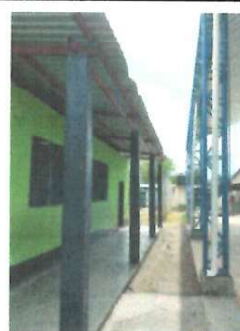
ESTRUCTURA DE TECHO, SUSTITUCION DE ESTRUCTURA DE TECHO EN MAL ESTADO, CUBIERTA DE LAMINA, SUSTITUCION DE LAMINA EN MAL ESTADO
