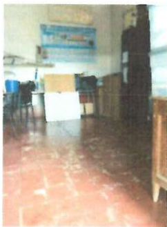
PISO, SUSTITUCION DE PISO DAÑADO EN DIRECCION, PINTURA EN MUROS, PINTURA EN MUROS EN DIRECCION
