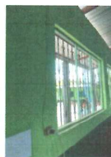
VENTANAS, SUTITUCION DE VENTANAS EN MAL ESTADO POR VENTANAS DE ALUMINIO CON PALETAS DE CRISTAL, MANTENIMIENTO DE BARANDAS, MANTENIMIENTO DE BARANDAS
