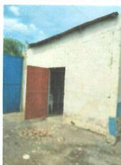
REPELLO Y CERNIDO, EN MUROS EXTERIORES
