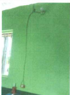
REPARACION DE SISTEMA ELECTRICO, SUSTITUCION DE SISTEMA ELECTRICO, CAMBIO DE CABLEADO, APAGADORES, TOMACORRIENTES, DUCTO
